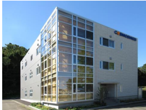
県内初の3階建てCLTパネル工法による建物
